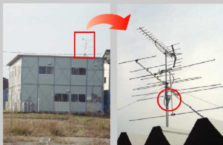
事務所のアンテナに無線LAN機器を設置。
